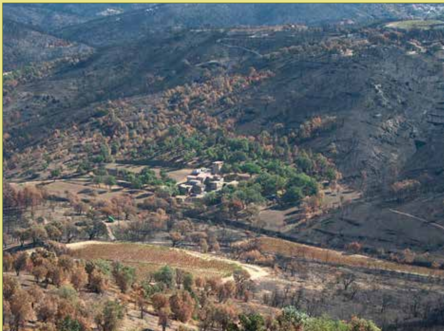
Maisons débroussaillées épargnées par le feu (Plan de la Tour, incendie du 22 juillet 2003).
